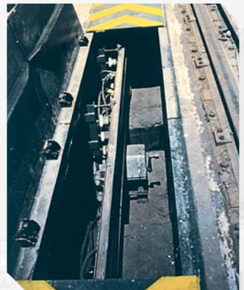
Canal de carriles con cubierta de chapa en Puerto.
